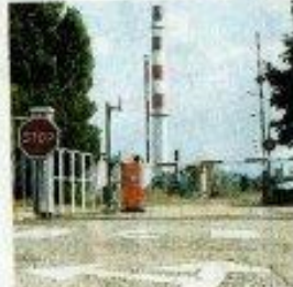
La raffinerie de Reichstett, fermée, va être démantelée et son sol dépollué. PHOTO DNA - CHRISTIAN LUZZI-SORG
