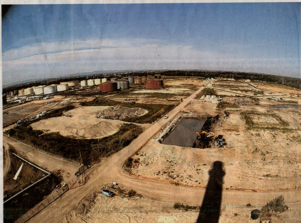
Un site gigantesque dont on ne voit ici qu'une partie. De vastes « piscines » ont été creusées pour extraire les polluants. Au fond, les installations de Wagram (dépôt pétrolier), société voisine du site acquis par Brownfields. DOCUMENT REMIS
