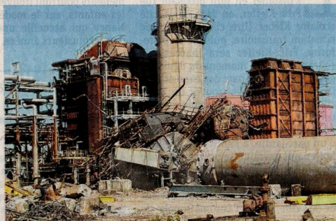
La phase « démolition » est achevée : 35 000 tonnes de ferraille et 800 kilomètres de ligne. DOCUMENT REMIS
